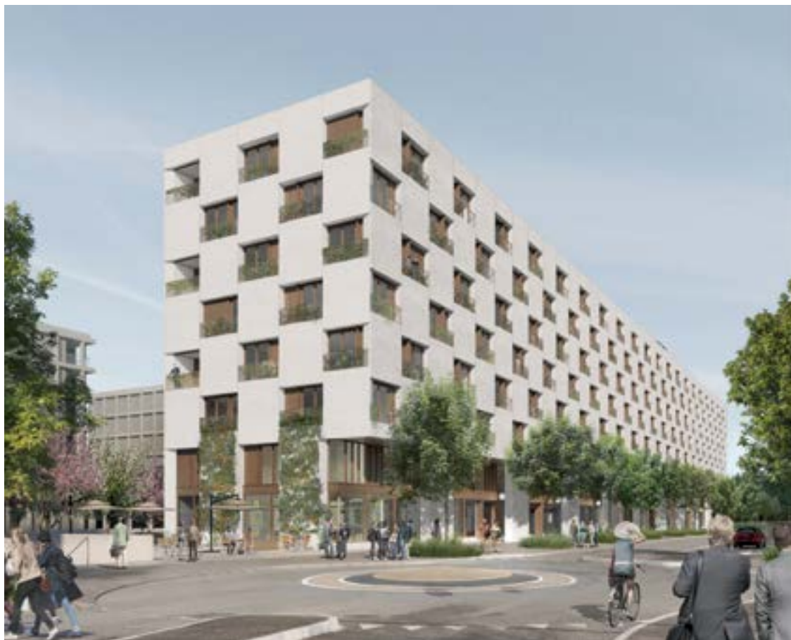
Au-dessus des arcades commerciales, 155 logements d'utilité publique accueilleront une diversité de locataires. LDD
